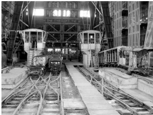
写真-25 住友赤平立坑ヤード
