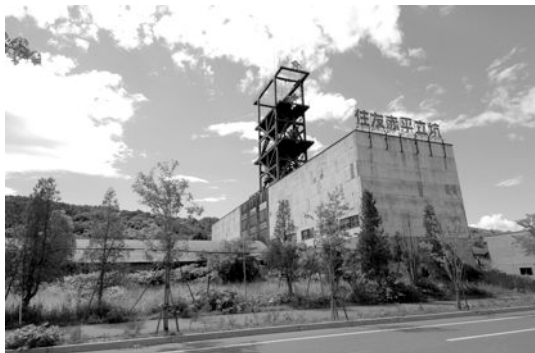
写真-1 住友赤平炭鉱立坑
